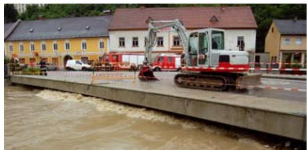
Eine der ersten Hochwasser-Maßnahmen: Geländer bei der Kremsbrücke abmontieren (24.6.2009, 7:00 Uhr)
